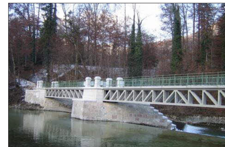
Dank der Handwerkskunst des Stahlbaubetriebes Schöfbenker erstrahlt der „Ischler Rechen“ im neuen Glanz.
